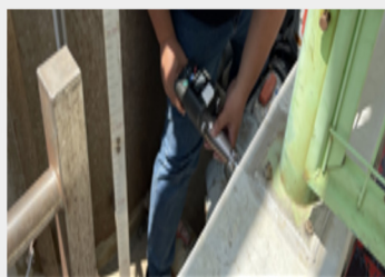
대장시설 방류벽 측정 (방류벽 및 바닥 강도 확인)
